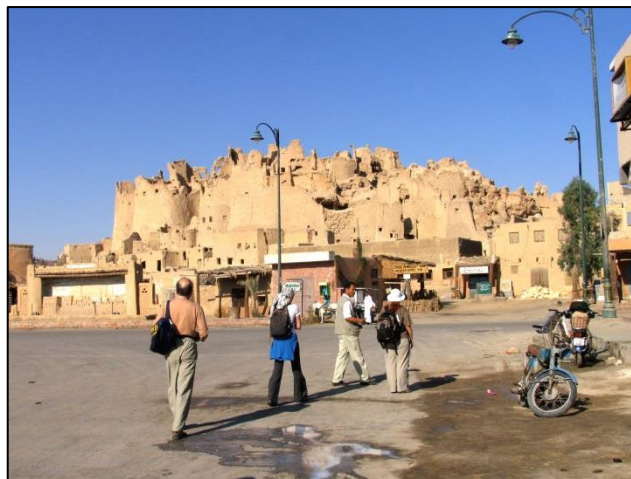
Staro mesto na griču Šali, zgrajeno iz slanega blata, je leta 1926 uničil močan dež
